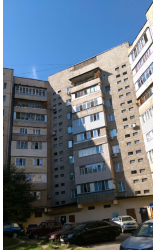
Figure 5. Rozybakiyeva, St., house 140, SZhKU-9
